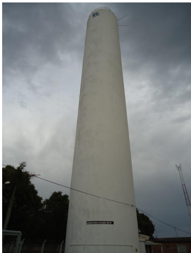
Foto 5 - Reservatório elevado de 100 m 3
