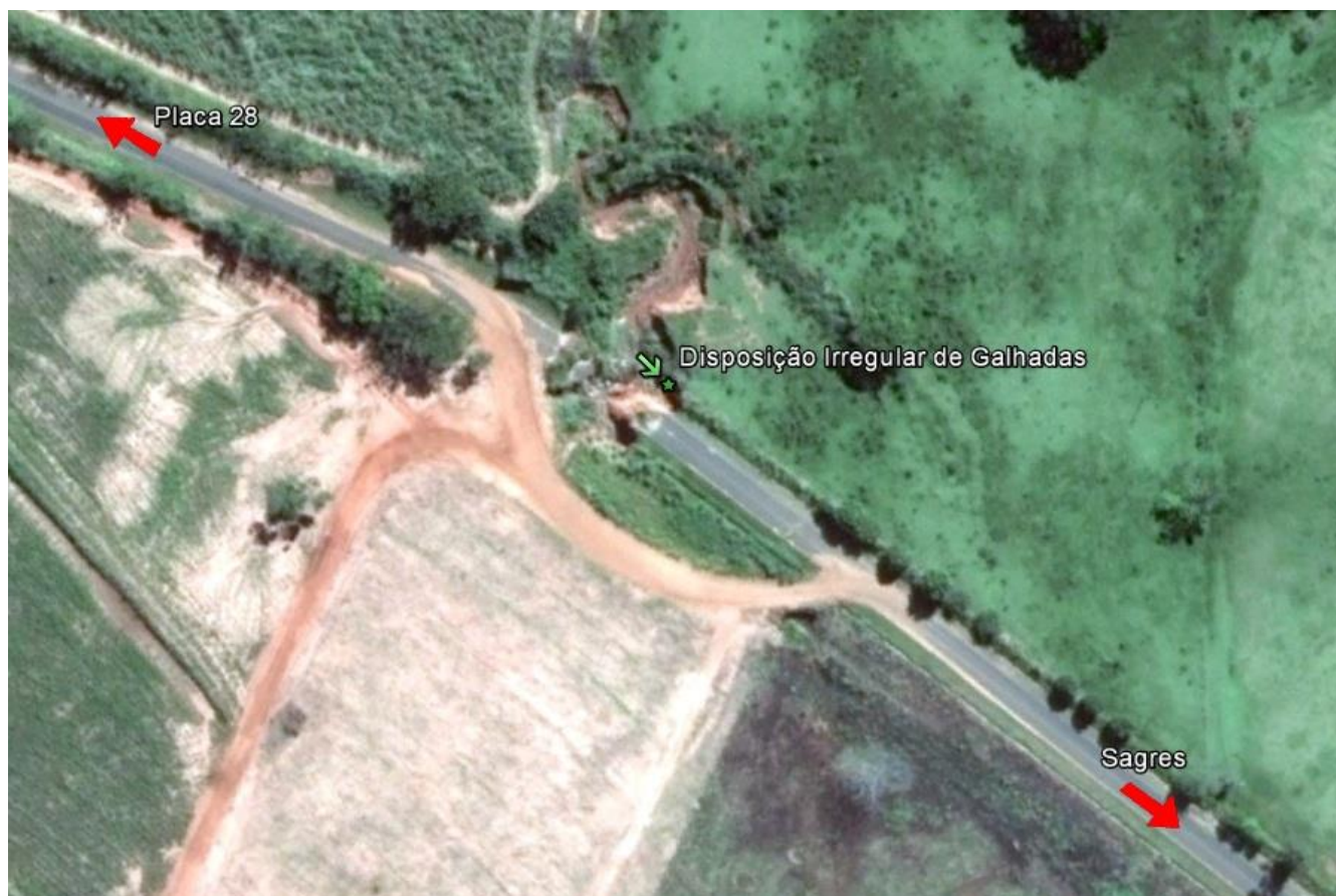
Imagem 12 - Deposição Irregular de Galhos
